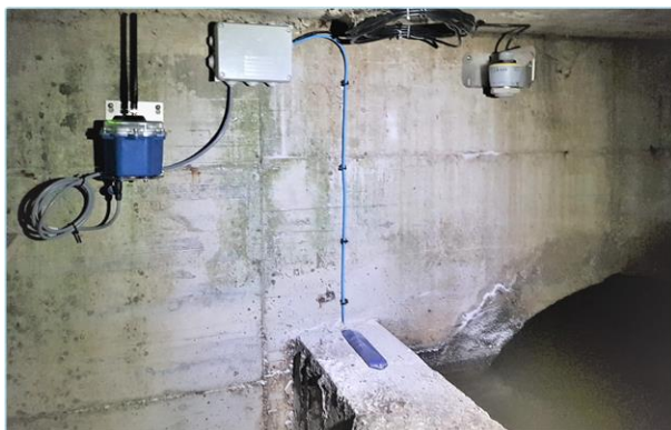
DETECCIÓN EN CONTINUO DE DESBORDAMIENTO CON SONDA CAPACITIVA INTELIGENTE, MEDIDA DE NIVEL CON TECNOLOGÍA RADAR Y ESTIMACIÓN DE CAUDALES CON ECUACIONES DE CONVERSIÓN
