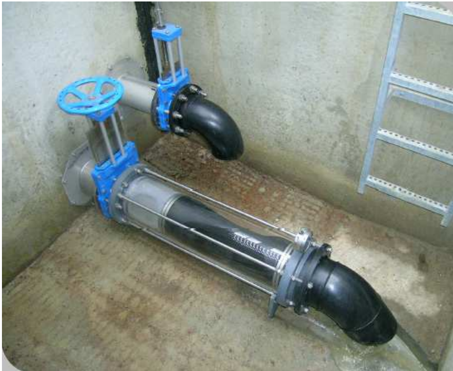
Figura 1: Instalación típica del FluidHose. Tipo U
