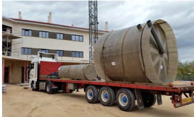
Tanque de tormentas compacto a su llegada en obra
