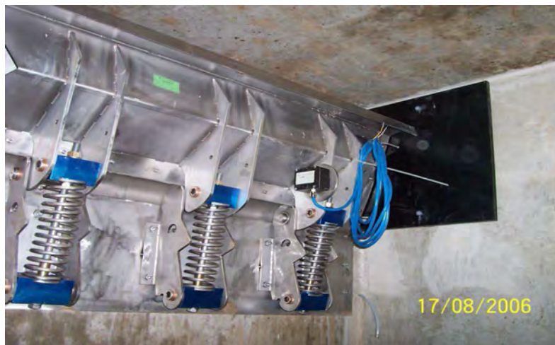
Aliviadero flexible instalado en España
