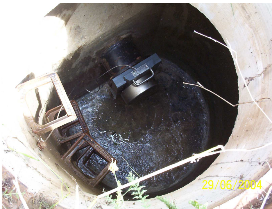
REGULADOR VORTEX VERTICAL CLEAN WATER-UFT FLUIDVERTIC, TIPO VLS DN 100, PARA UN CAUDAL MÁXIMO DE 10 l/s Y UNA ALTURA DE 1 METRO.
